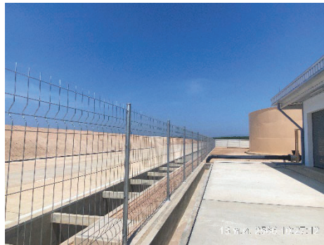
ภาพที่ 2-7 แผงรั้วกันกำหนดขอบเขตพื้นที่ก่อสร้าง
