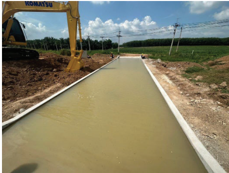
ภาพที่ 2-11 พื้นที่ล้างทำความสะอาดล้อรถบรรทุก
