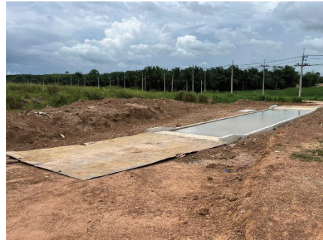
ภาพที่ 2-11 พื้นที่ล้างทำความสะอาดล้อรถบรรทุก
